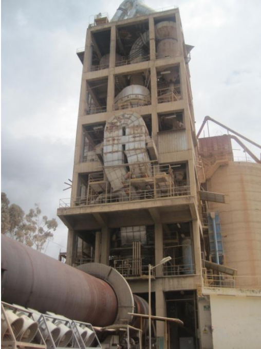
Foto N°1 Torre de precalentamiento
