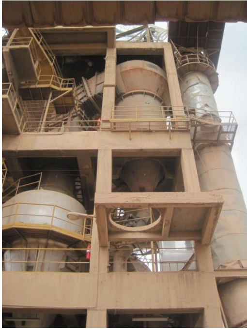
Foto N°5 Etapas Torre de Pre calentamiento
