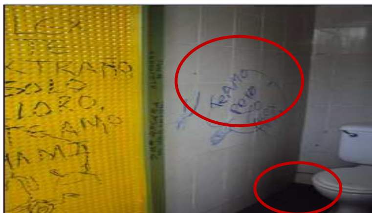
Fotografía 7. Baterías satinarías malas condiciones.
