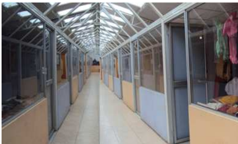
Fotografía 8. Locales vacíos y cerrados
