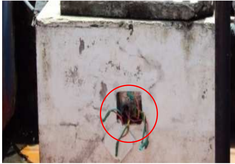
Fotografía 13. Conexiones inadecuadas.
