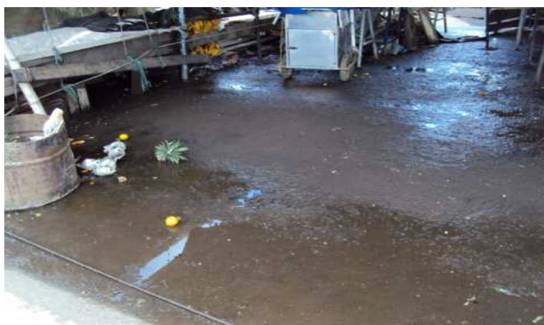
Fotografía 10. Falta de canalización diferentes zonas del mercado.
