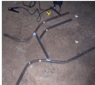
Figura 173. Soldadura de los tubos interiores
