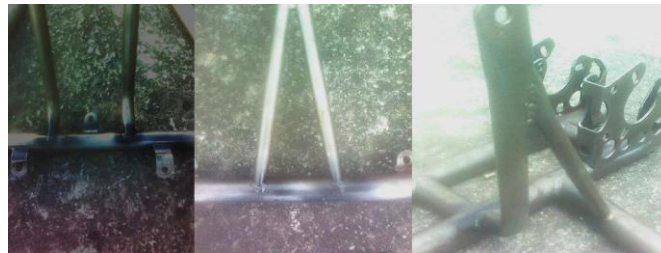
Figura 185.Soldadura de anclajes del asiento, soporte del volante y soporte del tanque de combustible.
