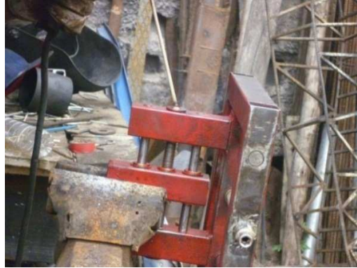
Figura 56. Operación de relleno mediante soldadura para adaptación de motores al mecanismo de modificación del camber
