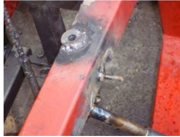
Figura 124. Operaciones para el acoplamiento de la columna de la dirección
