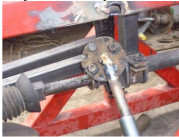
Figura 123. Acoplamiento de la junta cardán y soldadura de la columna de la dirección
