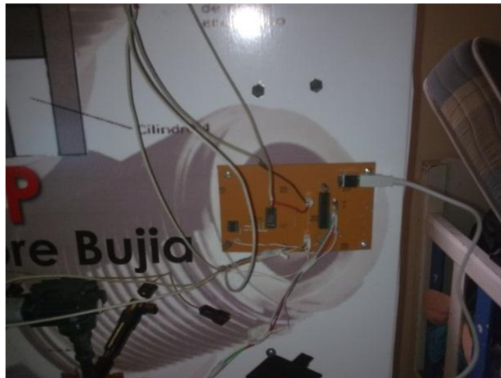
Figura 107. Colocación de módulo de encendido
