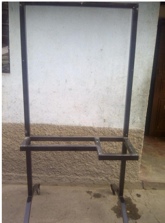
Figura 98. Construcción de estructura
