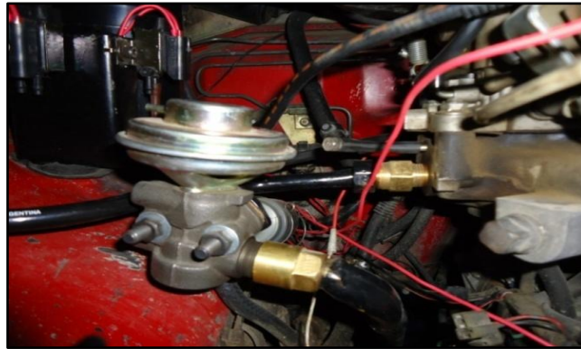
Figura 51. Instalación de la válvula EGR
