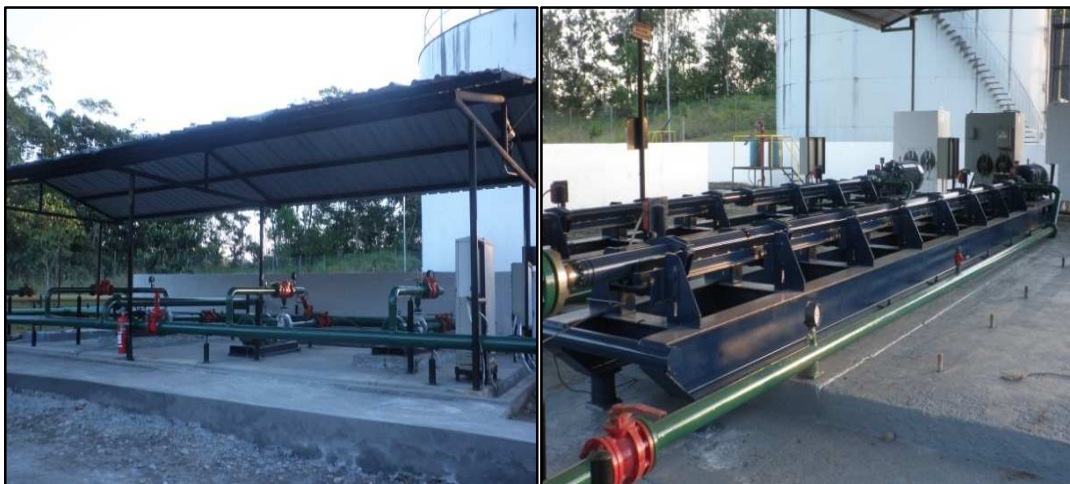
Figura13. Área de reinyección de agua de formación
