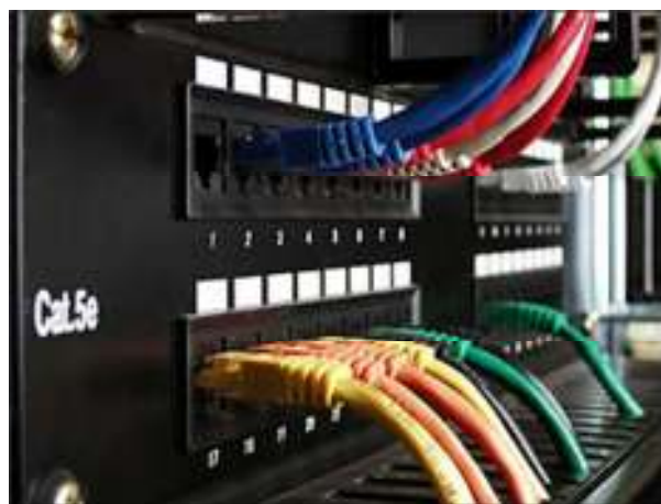
Figura II. 23 Panel de parcheo de la categoría 5e con patchcords
