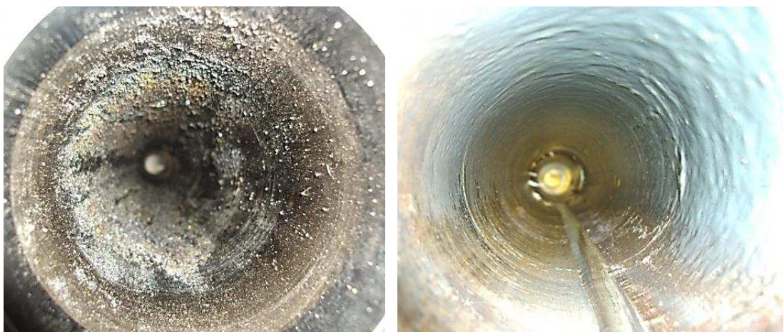
Figura 59. Limpieza del interior del cilindro o camisa
