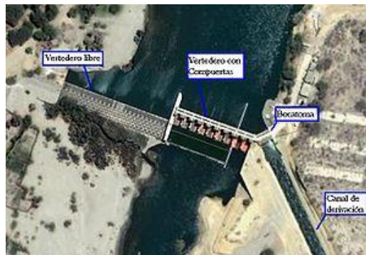
Figura 25. Represa de barrage movil
