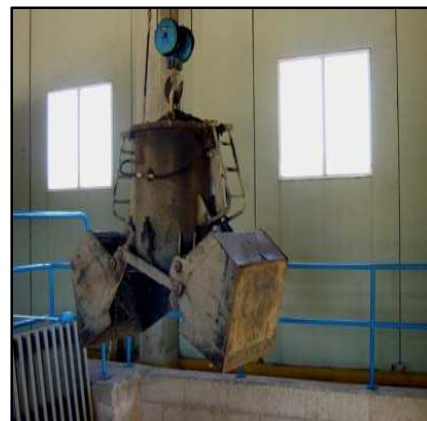
b) Estructura en cuarto
