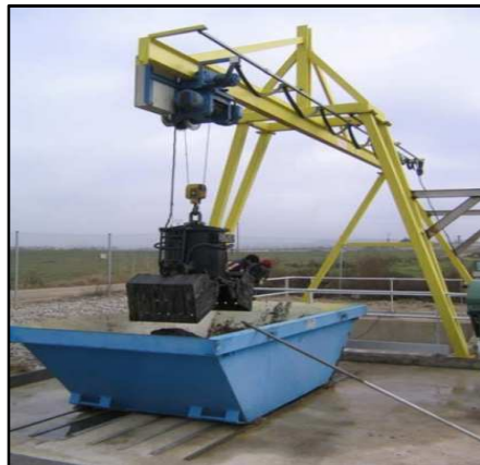
a) Estructura abierta
