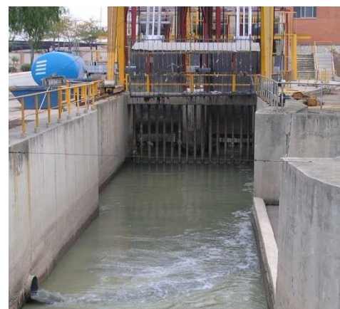
d) Entrada canal con rejilla
