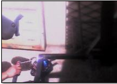
Figura 41. Soldadura de la estructura metálica.
