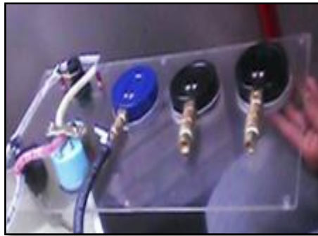
Figura 57. Instalación de los componentes de control.
