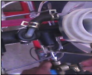
Figura 144. Montaje de tuberías primario y secundario
