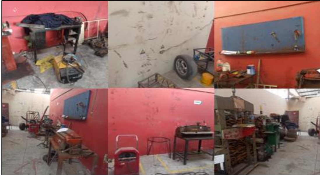
Ilustración 3-8: Estado actual del Área de Trabajos con Elementos Metálicos del Taller Institucional Automotriz.
