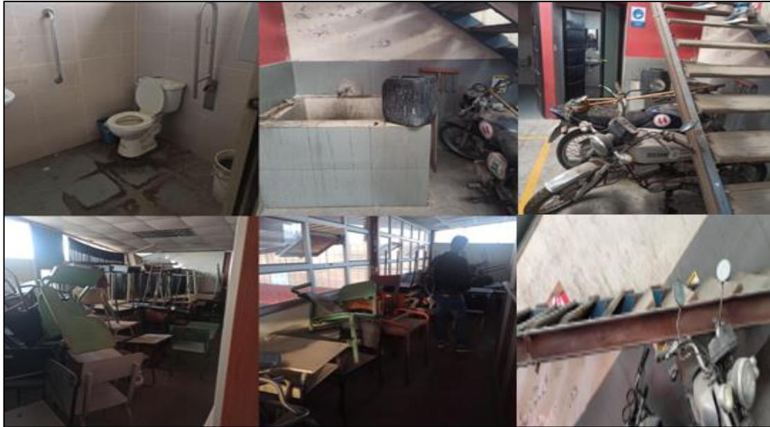
Ilustración 3-14: Estado actual del Área de capacitación, baños y vestidores del Taller Institucional Automotriz.
