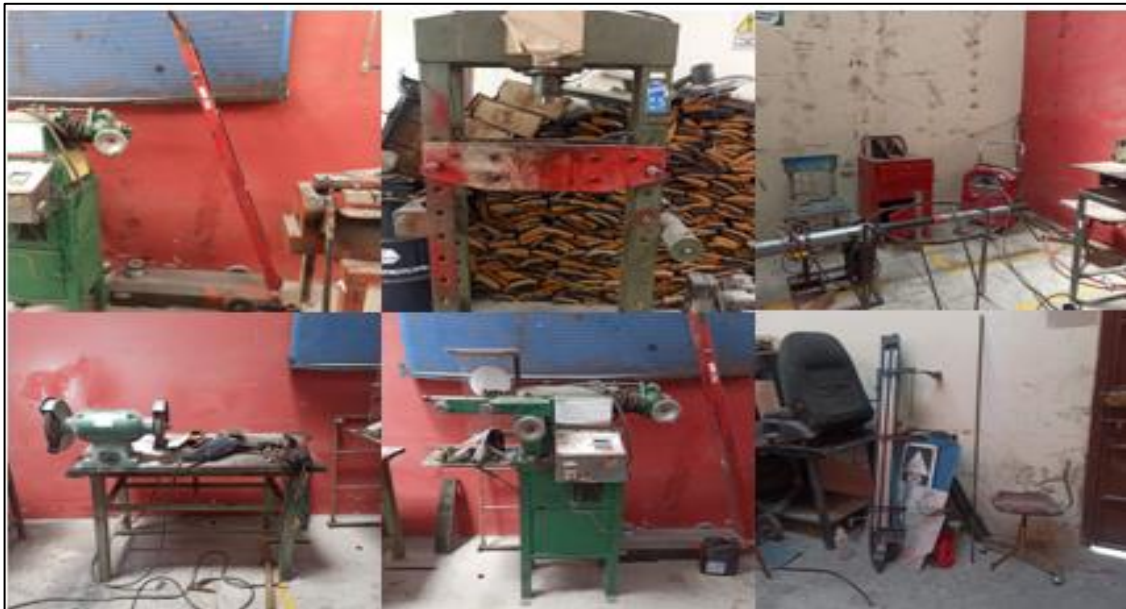
Ilustración 3-7: Estado actual del Área de Trabajos con Elementos Metálicos del Taller Institucional Automotriz.
