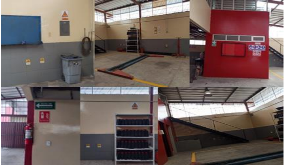
Ilustración 4-17: Estado del Área de Elevadores de Trabajo del Taller Institucional Automotriz después de implementar las 5S de Kaizen y los sistemas de Gestión.
