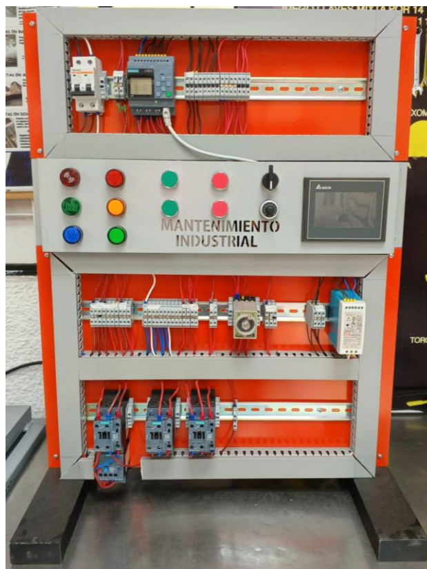
Ilustración 4-4: Resultados del cableado del módulo
