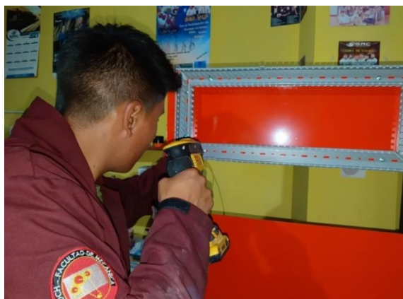
Ilustración 3-8: Sujeción mecánica de canaletas
