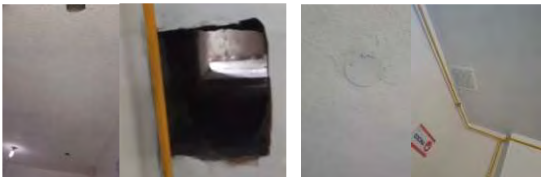
Figura 5-4: Agujeros en el techo de la planta (antes y después)
