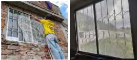
Figura 9-4: Colocación de malla en ventanas
