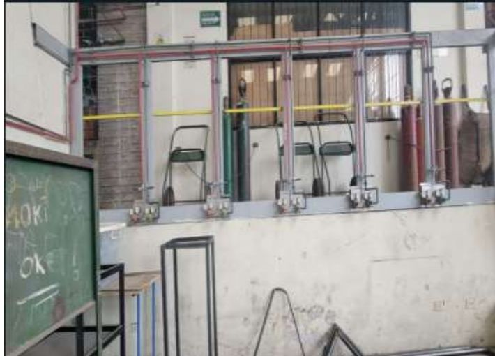
Ilustración 3-8: Área de soldadura oxiacetileno
