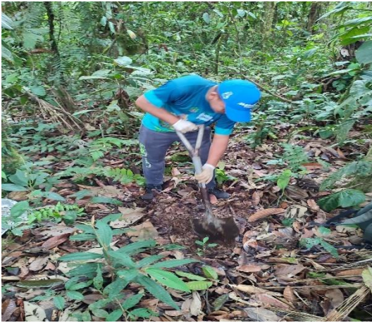
1. Excavación de la calicata
