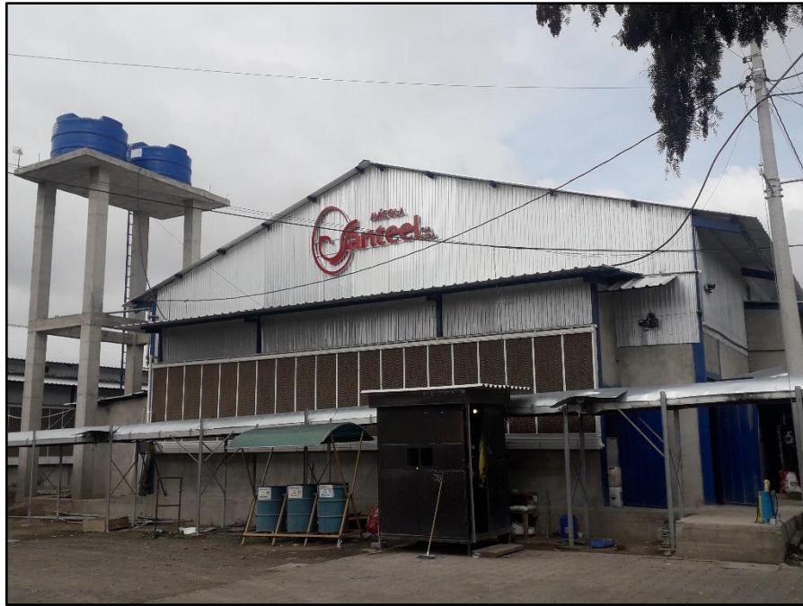
Paneles húmedos frontales del galpón
