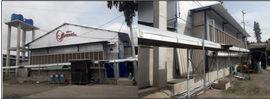
Figura 5-2: Paneles húmedos frontales y laterales del galpón.
