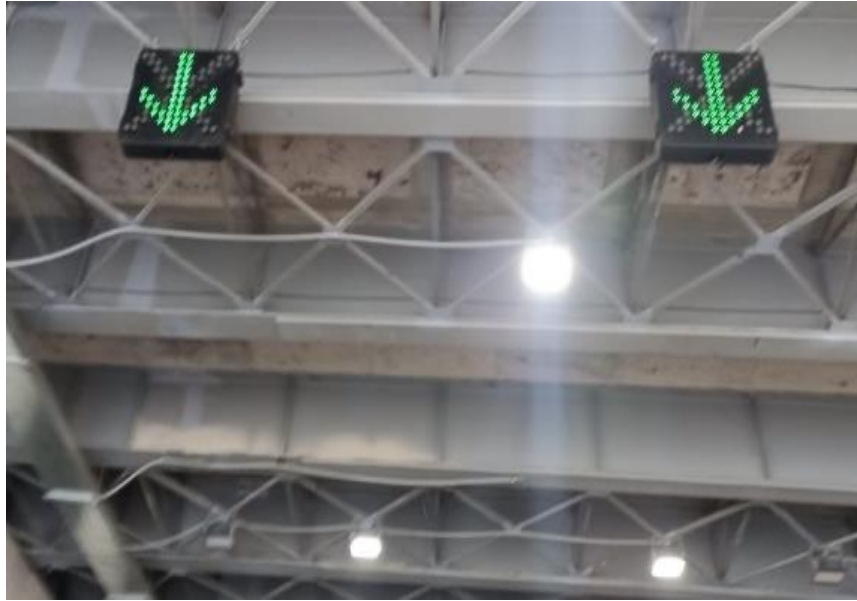
Figura 3-5: Señalización complementaria, indicadores de carril
