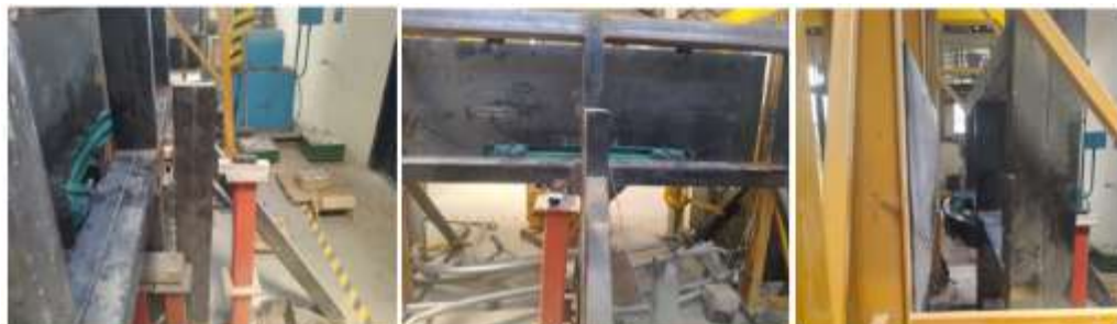
Figura 59-3. Preparación del parachoques para el ensayo de impacto
