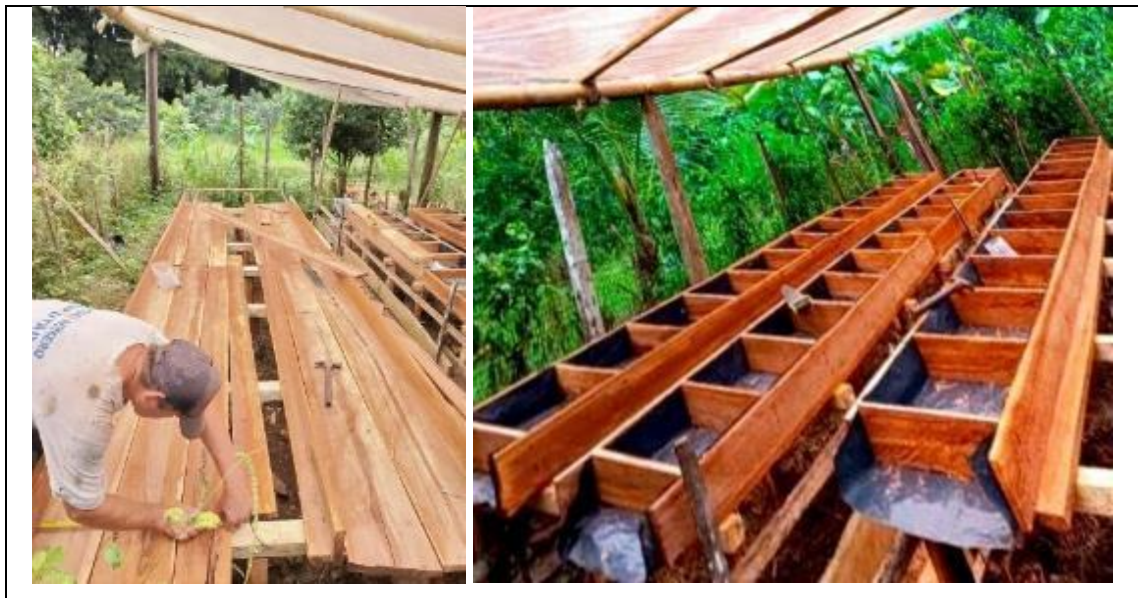
Ilustración 3-2: Armado de la infra estructura y construcción de los bloques para el diseño DBCA Realizado por: Aguilar, B., 2024.
