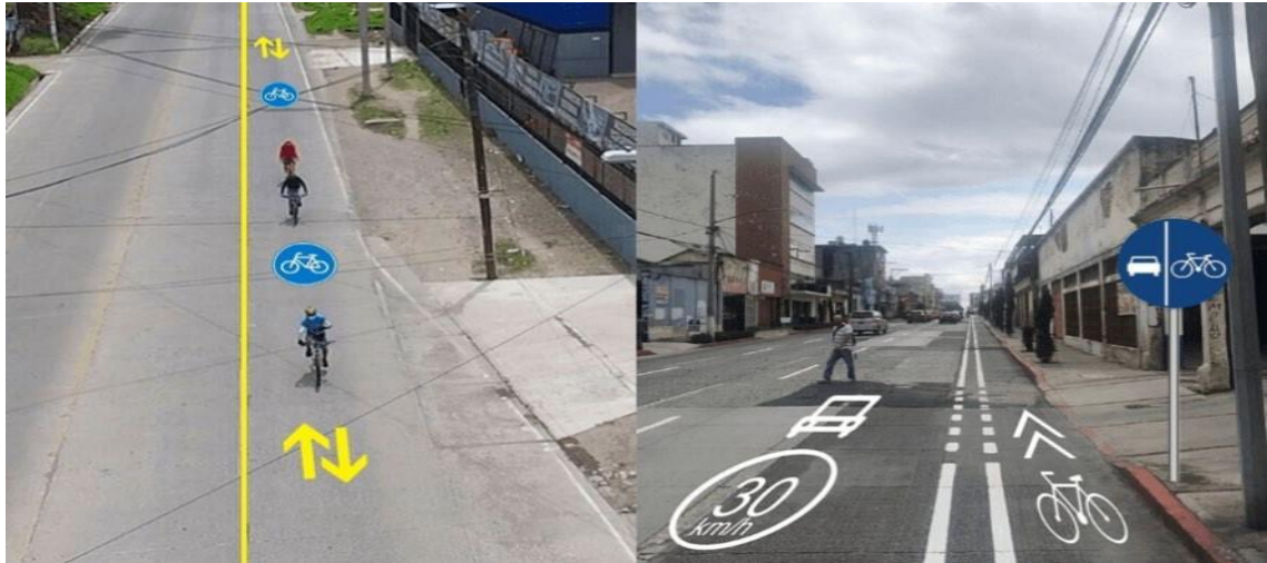
Figura 36-5: Señalización, cruce de ciclistas en intersección
