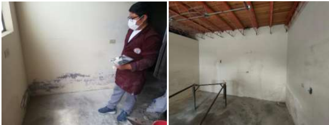
Ilustración 4-6: Empastado de paredes de la oficina
