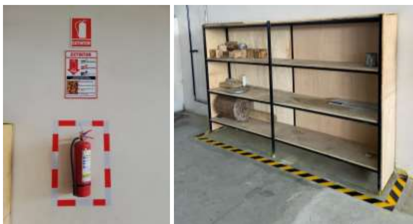
Ilustración 4-18: Demarcación de extintores y anaqueles
