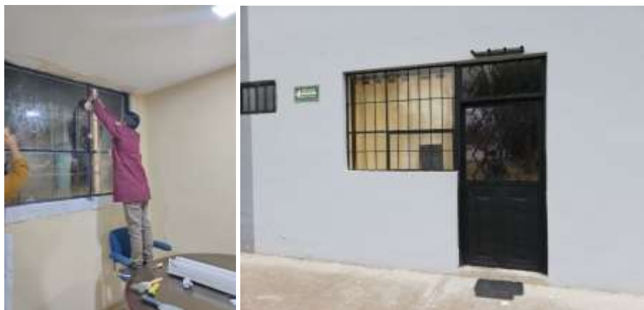
Ilustración 4-10: Resultado final de ventanas y puerta
