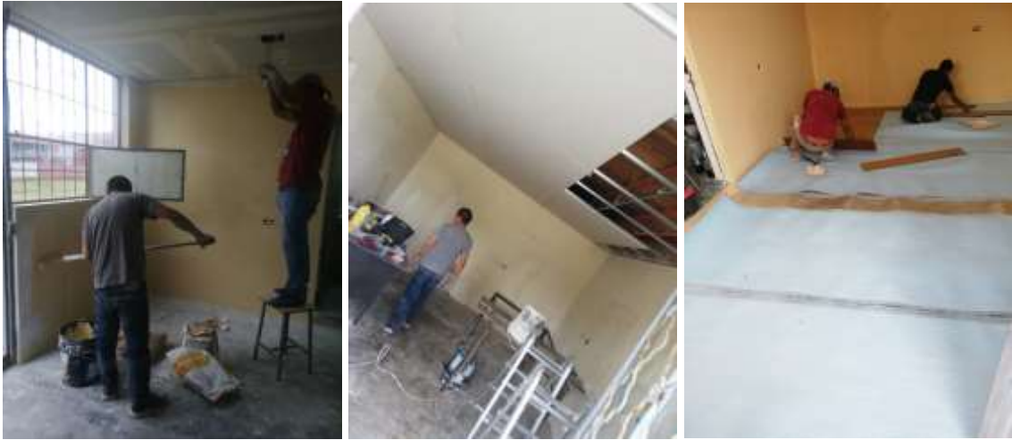
Ilustración 4-7: Adecuación de la oficina
