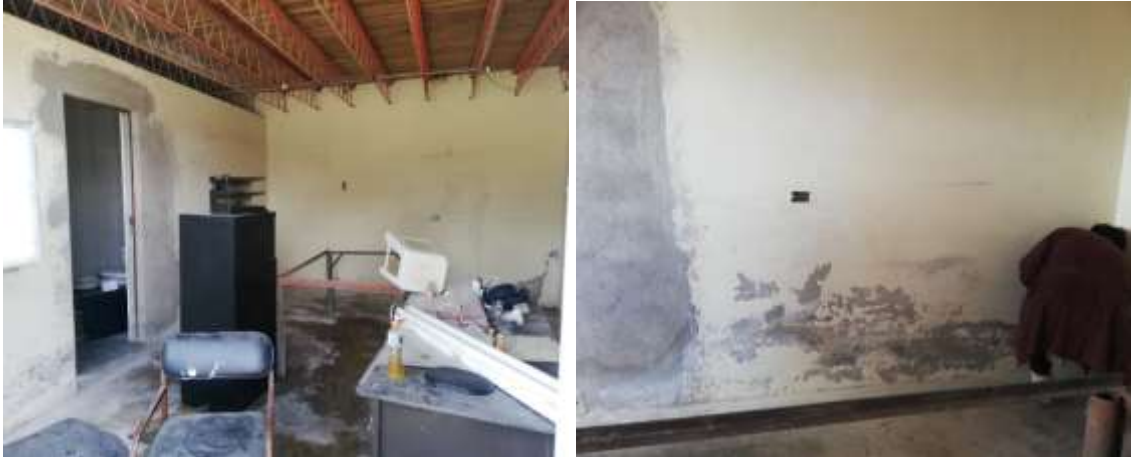
Ilustración 3-17: Oficina estado inicial
