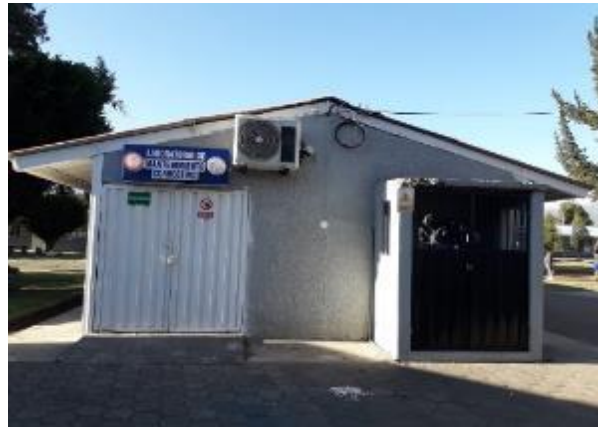
Ilustración 3-1: Laboratorio de Mantenimiento Correctivo
