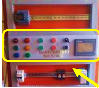
Ilustración 3-35: Colocación de los componentes
