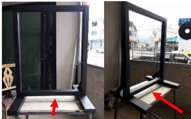
Ilustración 3-31: Armado de la estructura de aluminio
