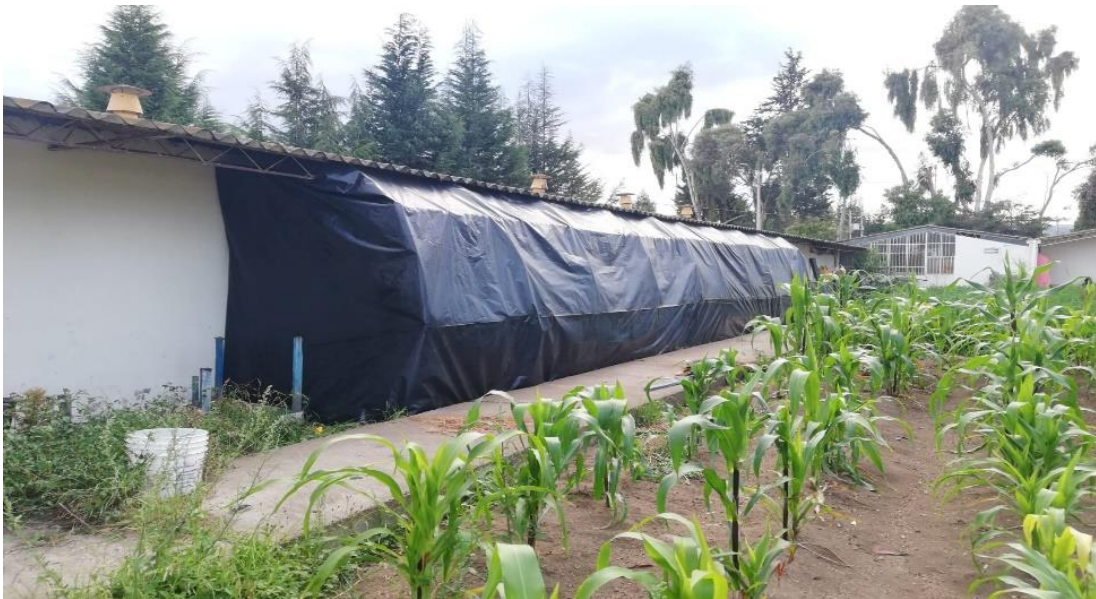
Ilustración 3-5: Instalación cubierta plástica con protección de rayos UV para invernadero
