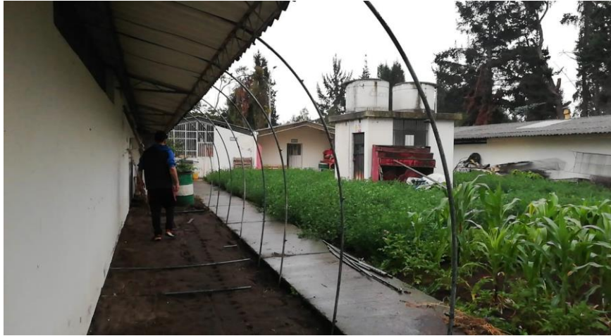
Ilustración 3-4: Instalación estructural tipo semi-túnel para invernadero
