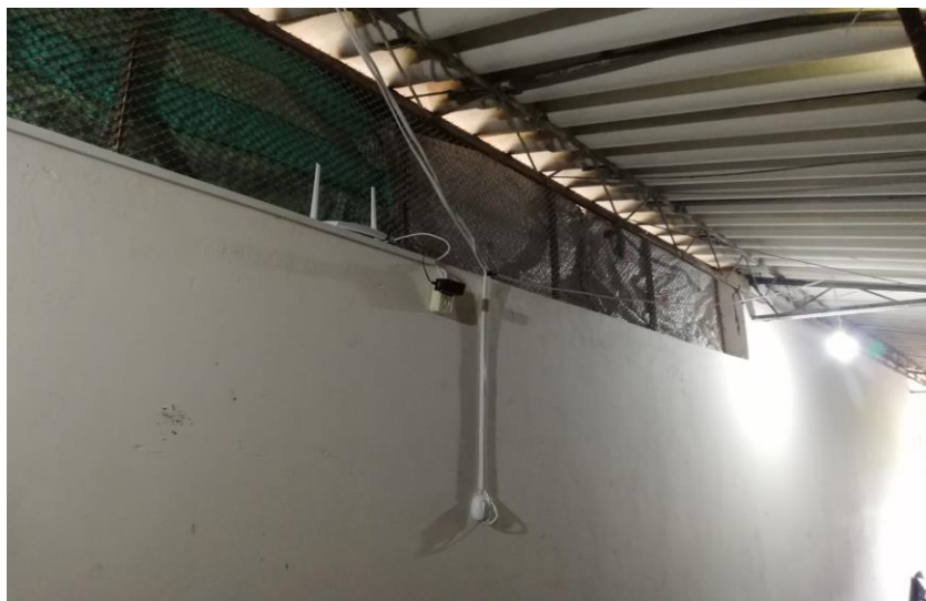
Ilustración 3-8: Instalación puntos de carga y puntos de iluminación Realizado por: Pulla D., Gavilanes D, 2023
