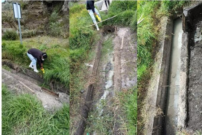
**Ilustración 4-5:** Limpieza del desarenador
