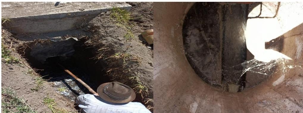
C. Daño detectado, obstruccion del Lechos de secado de lodos.
