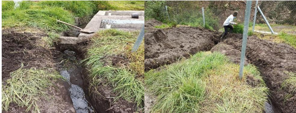
B. Ruptura de la Planta de Tratamiento de Aguas Residuales Ilapo I, para evitar la acumulacion de malos olores.
