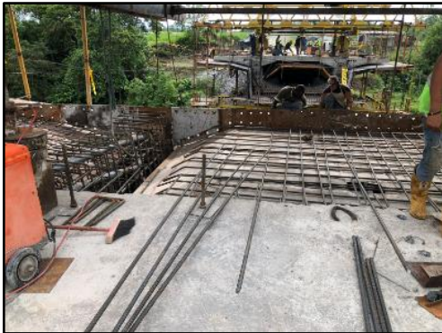
Actividades de encofrado
