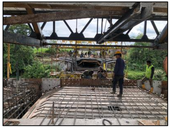
Zona de construcción
