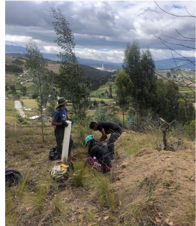
Colocación del tubo PVC para la impermeabilización del sistema E-PERM
