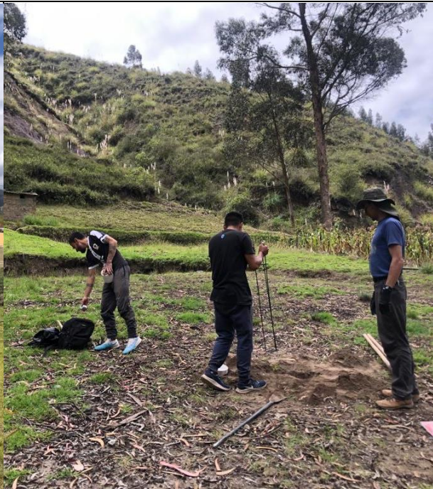
Colocación de la estructura para los equipos
