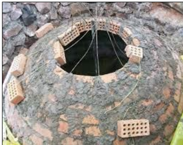
Ilustración 2-1: Biodigestor tipo chino domo fijo
