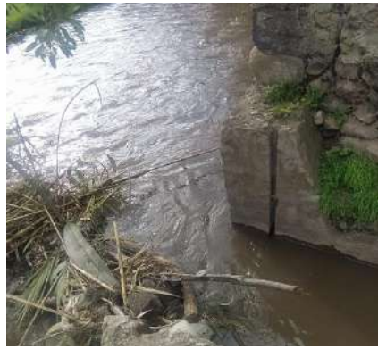
D2. Bocatoma del canal de Riego Pantus
