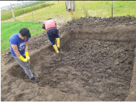
Excavación del terreno para el reservorio
