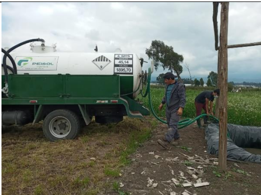
Descarga del lodo residual
