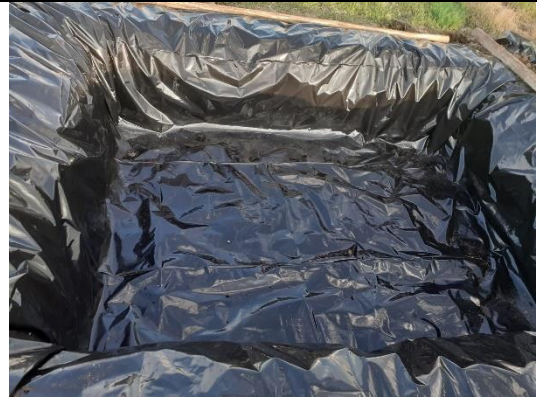
Colocación de la geomembrana
