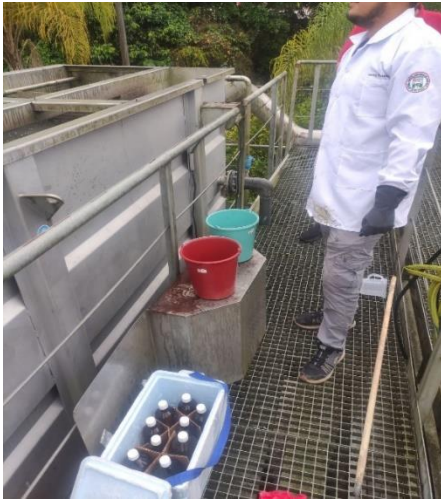
Fango activado - Tanque Aerobio
