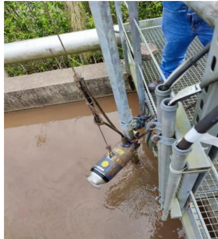
Trubinas del tanque aerobio
