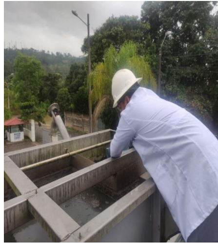
Fango activado - Tanque Aerobio
