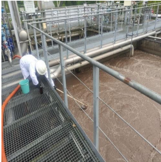
Fango activado - Tanque Aerobio
