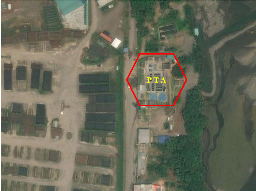
Ilustración 3-4. Planta potabilizadora Los Álamos
