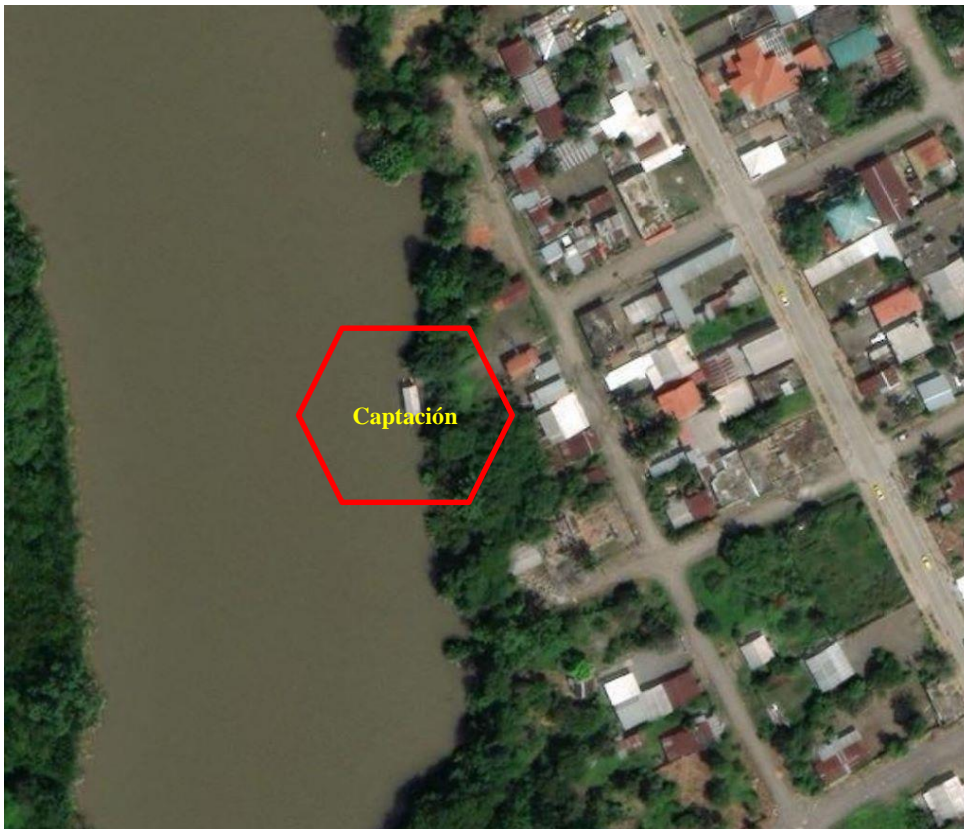
Ilustración 2-4. Captación de agua del río Payamino
