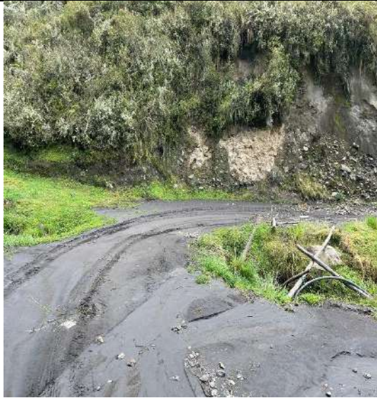
Camino de acceso a la fuente hídrica
