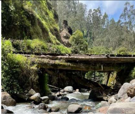
Puente de acceso
