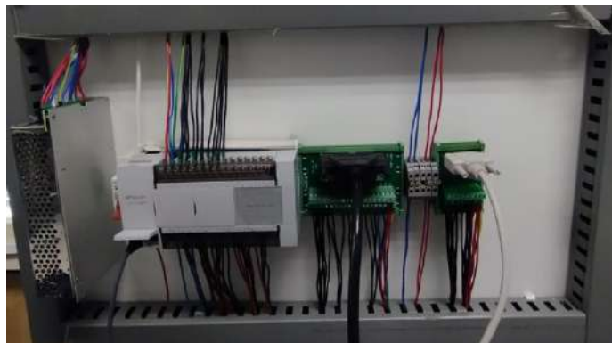
Ilustración 3-37: Ensamblaje físico del tablero de mando
