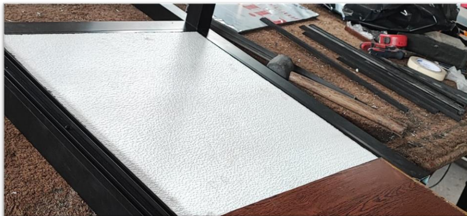
Ilustración 3-43: Cubierta de alucobond y relleno de poliestireno.
