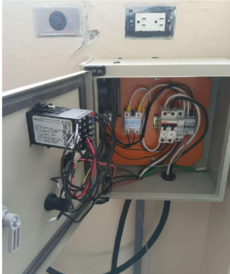
Ilustración 3-33: Implementación del tablero del horno B
