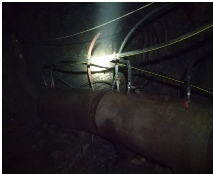
Ilustración 3-8: Tanques de aire a presión en mal estado
