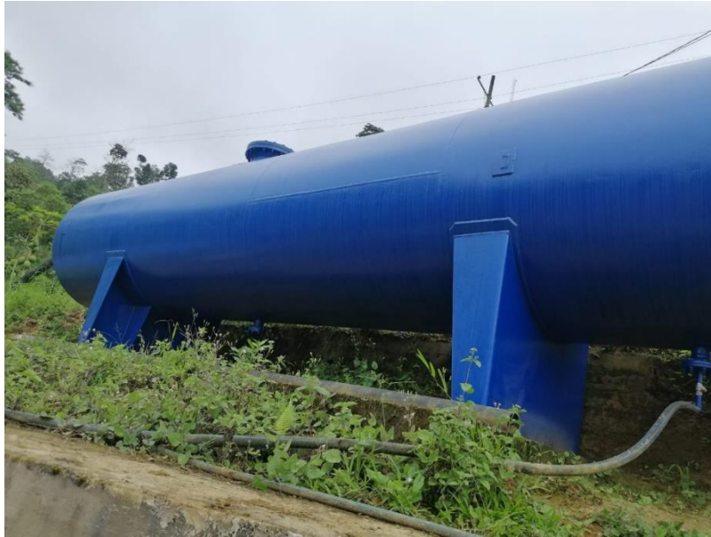
Ilustración 3-7: Pulmón o tanque de aire
