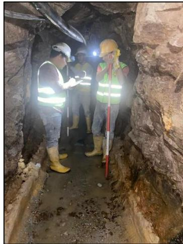
**Ilustración 8-3:** Control de cinta para el levantamiento topográfico con cinta y brújula.
