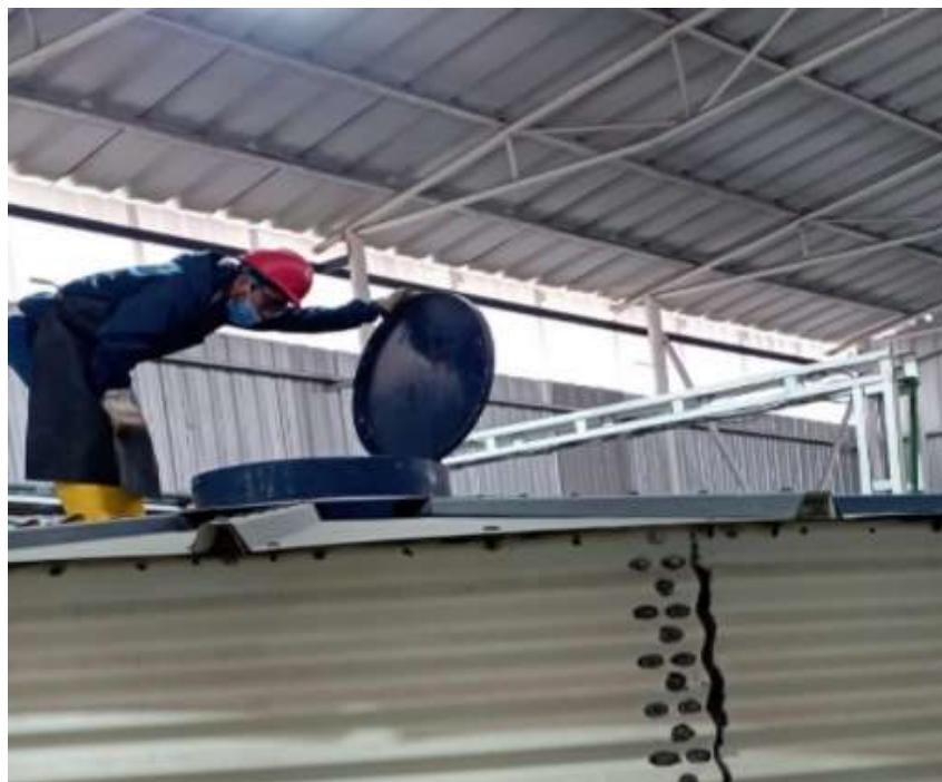
Ilustración 2-2: Verificación de nivel de tanque de almacenamiento
