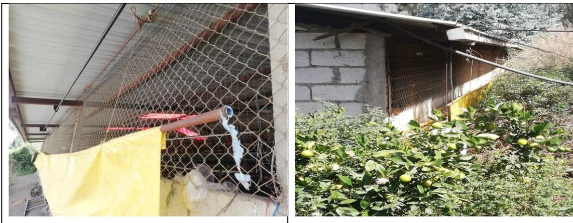
**Figura 3-3:** Ventanas de ventilación del galpón
