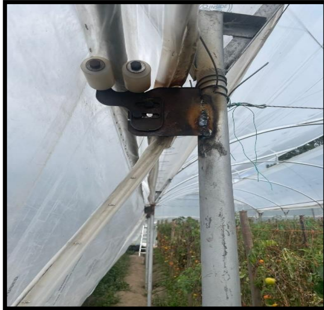
Ilustración 21-3: Acoples para enrollar las cortinas
