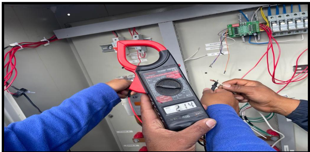
Ilustración 19-3: Validación de voltaje en caja térmica del invernadero experimental
