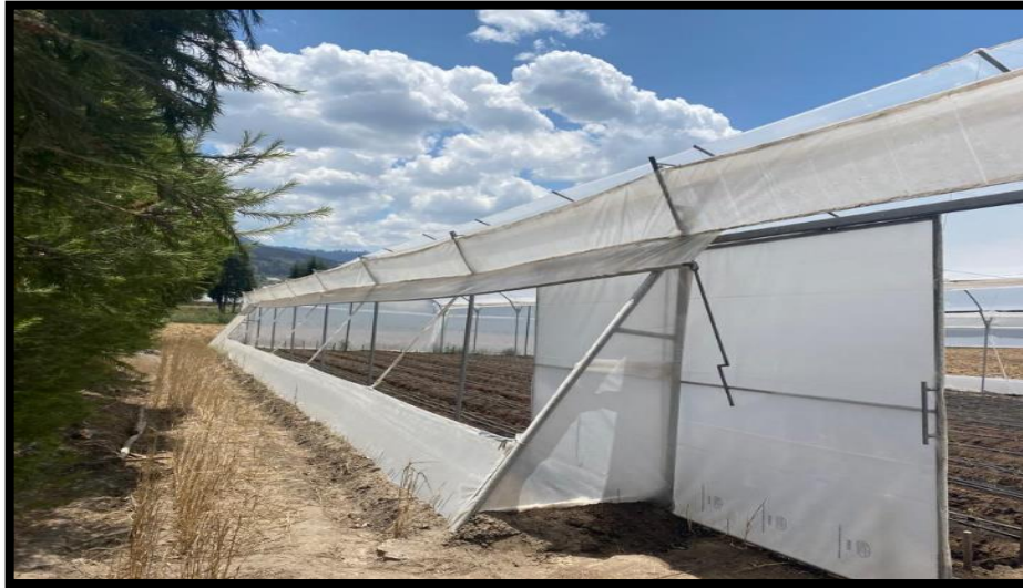
Ilustración 4-2: Cortinas del invernadero de la estación experimental Tunshi
