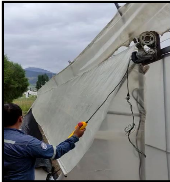
Ilustración 20-3: Sistema mecánico de cortinas
