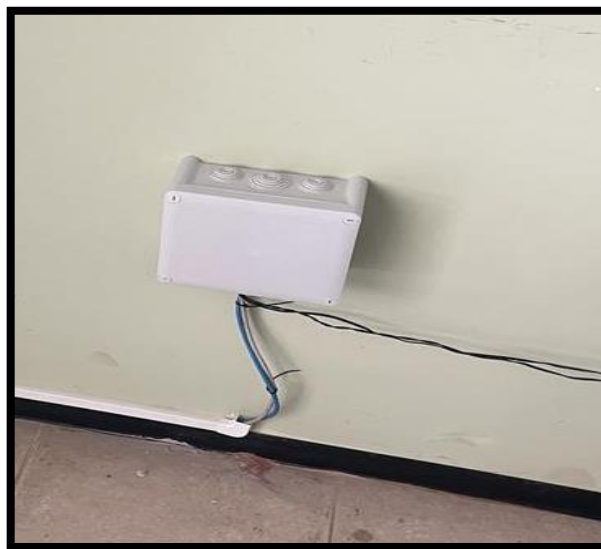
Ilustración 41-3: Caja principal de router matriz
