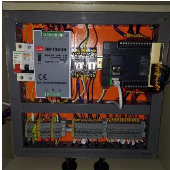
**Figura 43-3:** Disposición de elementos en el tablero
