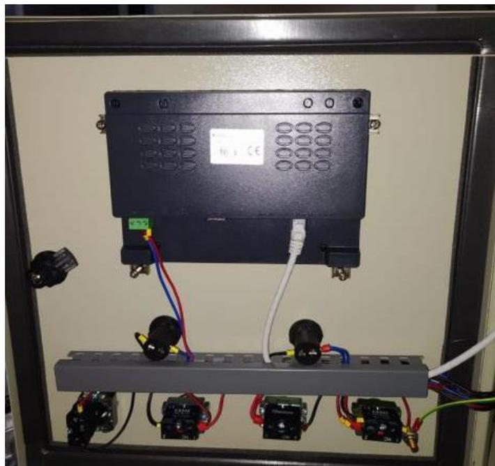
**Figura 44-3:** Cableado del panel frontal del tablero
