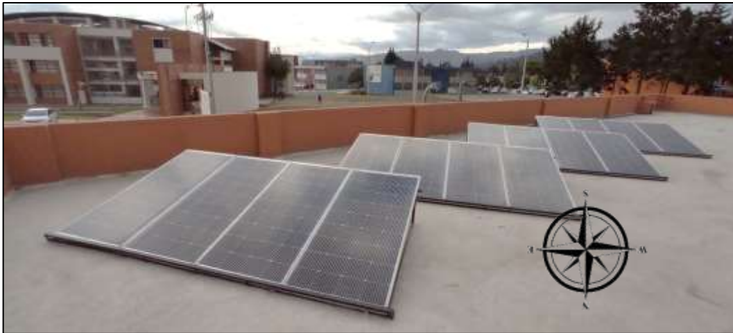
Ilustración 54-3: Ramas de paneles instalados.
