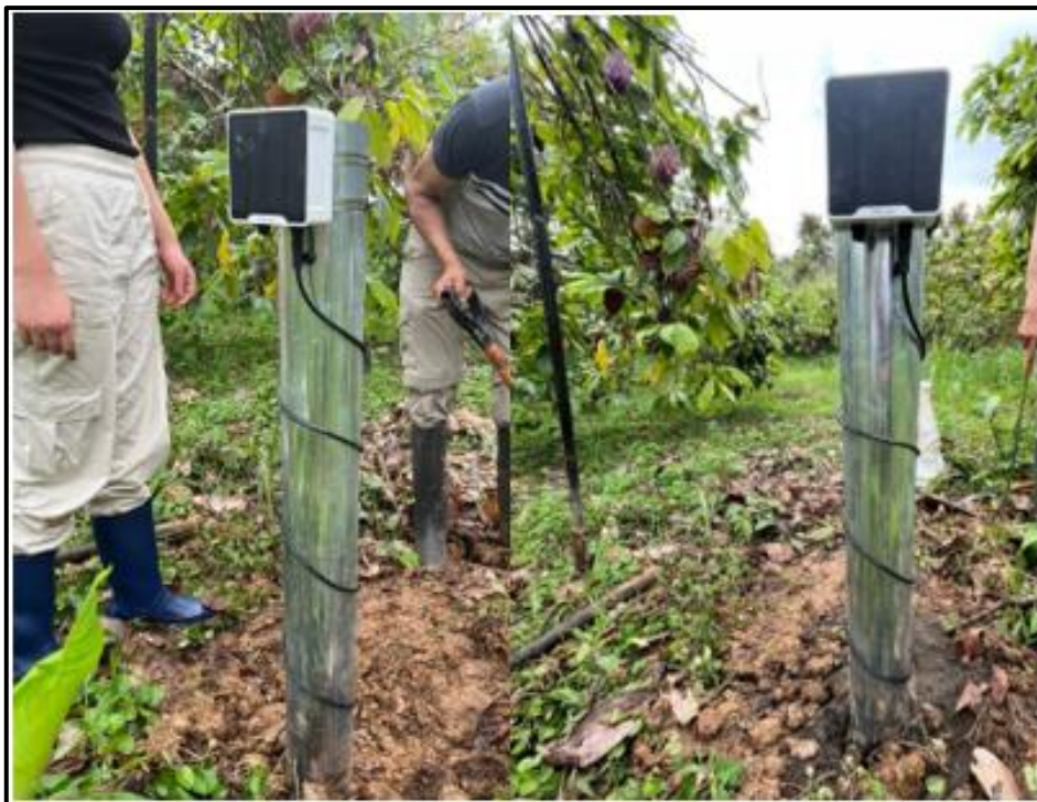
Ilustración 10-3: Montaje en poste del primer nodo Lora con el controlador.
