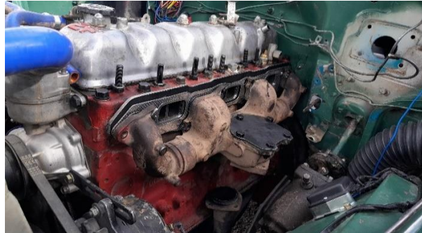
Ilustración 3-8: Colocación de la placa en el múltiple de escape
