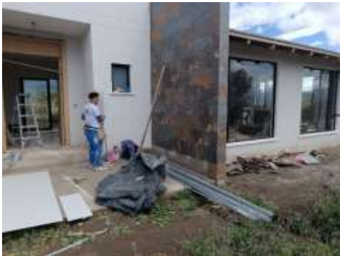
Ilustración 4-8: Recolección de desechos sólidos de construcción
