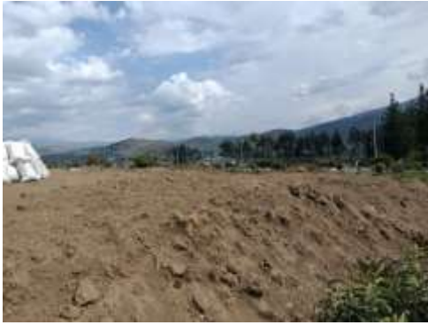
Ilustración 4-4: Suelo descubierto para proceso de construcción.
