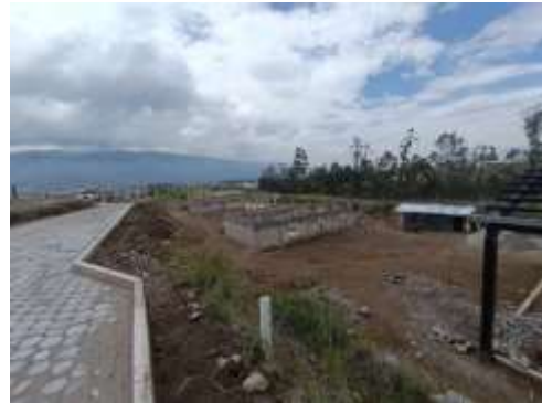
Ilustración 4-7: Construcción de coliseo y piscina.
