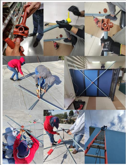
**I-1:** Proceso de instalación de antena CUADRA-CÚBICA sobre la loza del Edificio Modular de Electrónica y Telecomunicaciones
