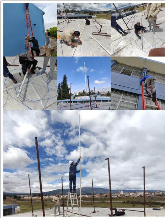
**G-1:** Proceso de instalación de antena DELTA LOOP sobre la loza del Edificio Modular de Electrónica y Telecomunicaciones
