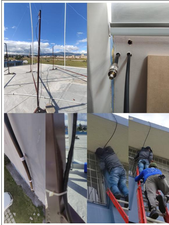
**Ilustración 3-50:** Tendido de coaxial a lo largo de la loza hasta el Shack de Radioaficionados
