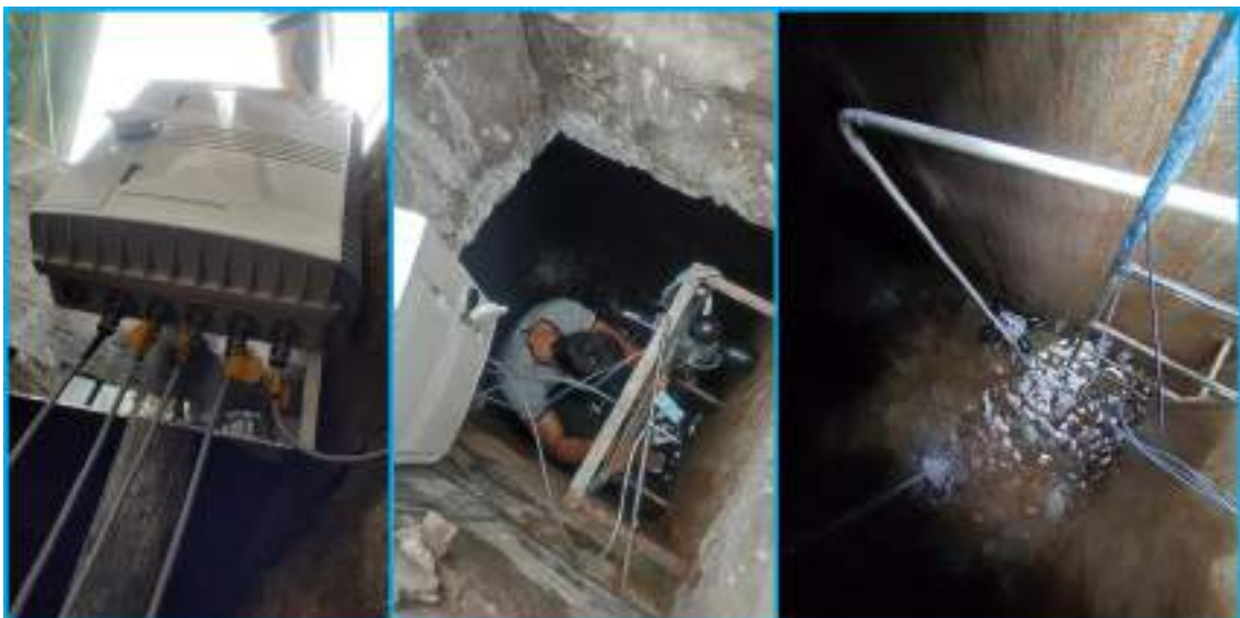
Ilustración 4-2: Incorporación de sistema flotante que contiene los sensores para nodo esclavo 1
