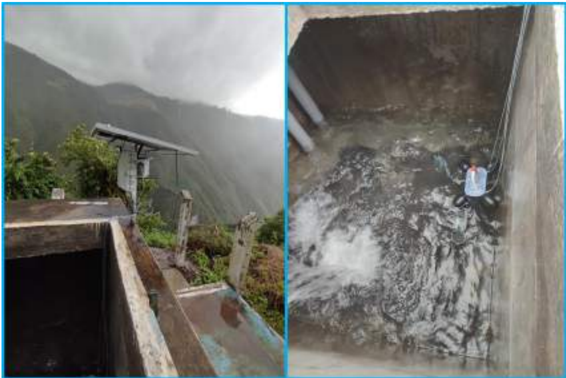
Ilustración 4-5: Incorporación de sistema flotante que contiene los sensores para nodo esclavo 2
