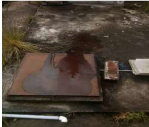
Pozo de descarga de agua residual
